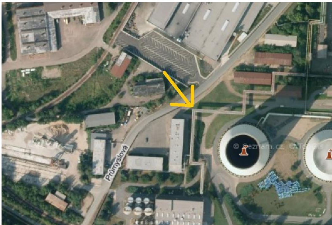
Obrázek 7: Připojné místo pro přehřátou vodu z chvaletické elektrárny
